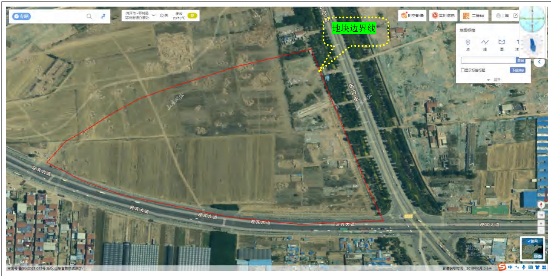
卫星拍摄时间：2019年6月，地块内居民住房房屋拆除。
