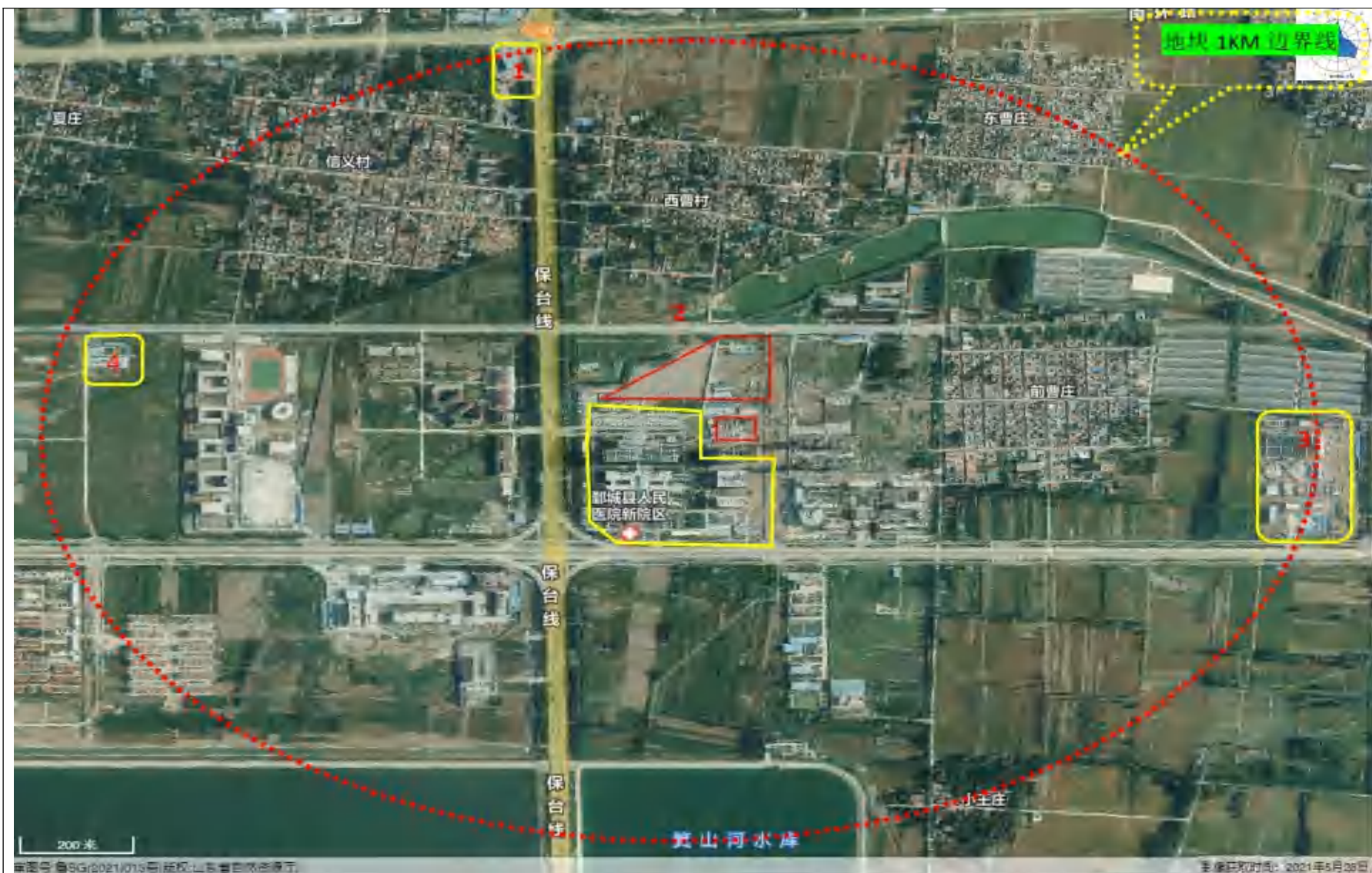
卫星图像拍摄时间：2021年5月。地块周边1km范围内主要为社区、村庄、学校、医院等。地块东侧936m新建鄆城县泓源水务发展有限公司③，西侧857m新建设润通商砼④。
