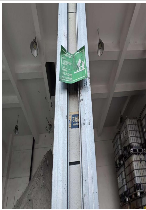
一般固废暂存间
